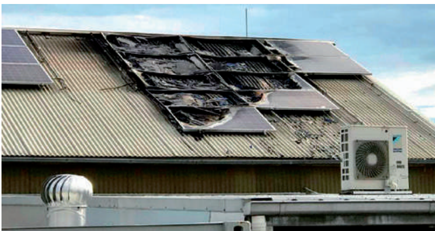
Fig. 13 Incendio fotovoltaico sobre panel no combustible.
